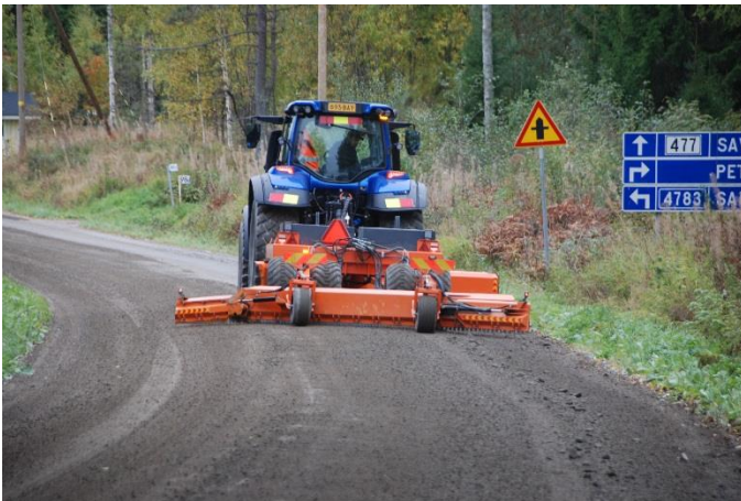
Kuva 1. Heinäveden alueella teitä hoidetaan MPH-lanalla.
