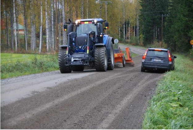
Kuva 6. Kun tiehoitoa tehdään yleisillä teillä, pitää huomioida muu liikenne. Vastaantulija väistää sopivasti, jotta lanaus etenee ilman katkoja. Kiviharjan jatko on nostettu ylös, jolloin työleveys on saatu kapeammaksi.
