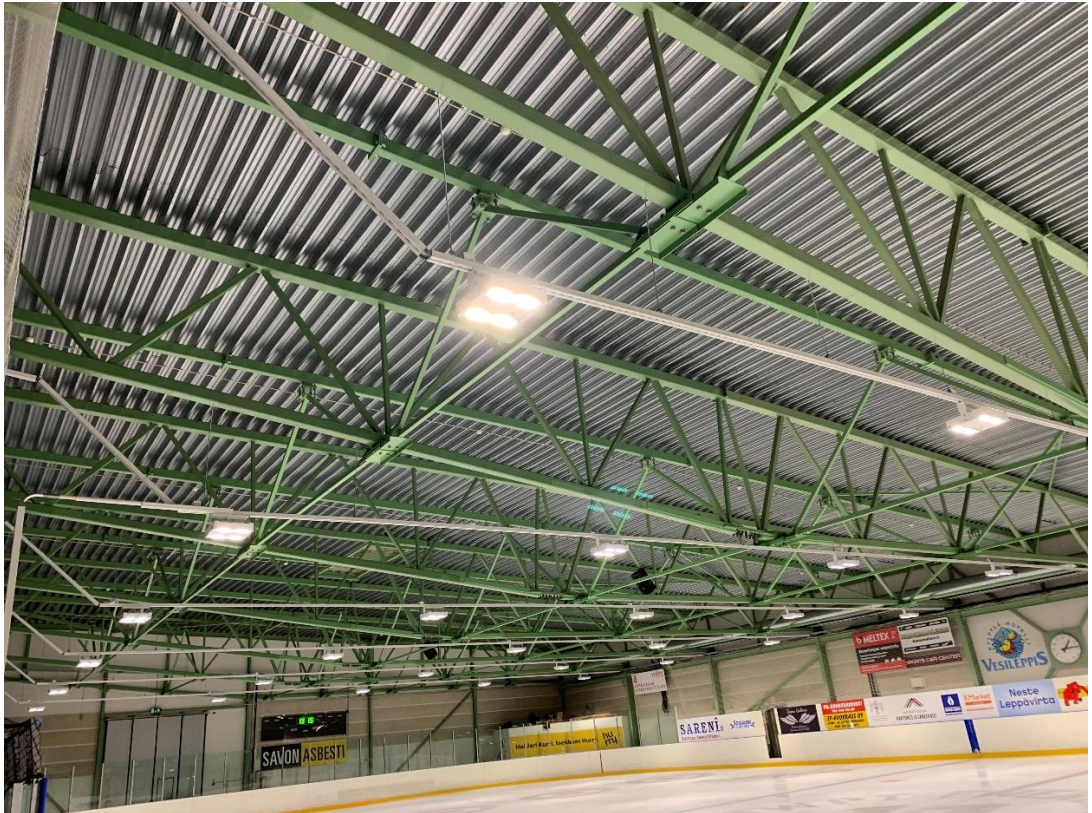
Kuva 4. Leppävirran jäähalli, nykyinen seinä- ja kattotukirakenne vahvistetun rakenteen kanssa.
