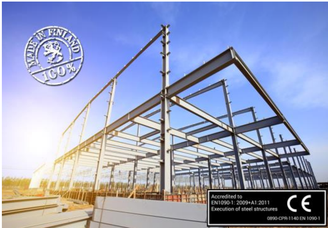
Picture 3. Metallipalvelu Hartikainen Oy.
